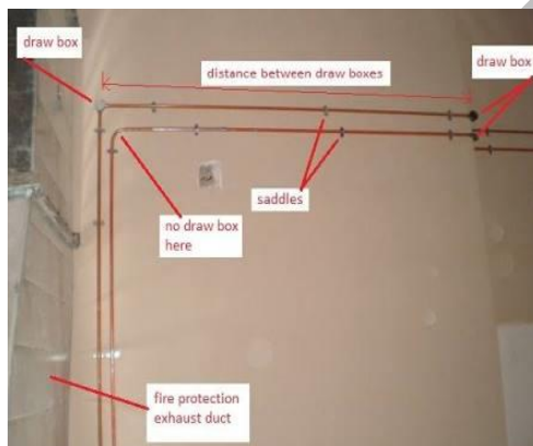
Conduit Wiring (concealed conduit wiring)
